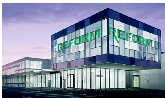
Verwaltungsgebäude Reform, Steyr (A)
